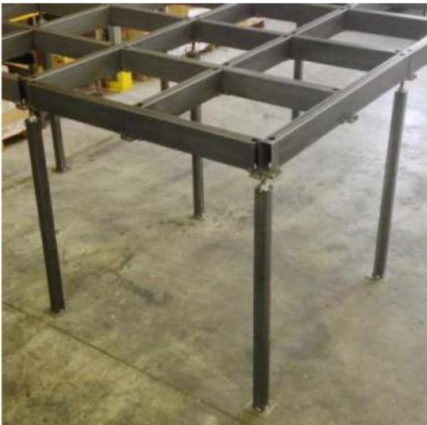
La estructura se puede suministrar para que las canalizaciones / bastidores se pueden atornillar directamente a la estructura inferior del Pavimento Técnico Elevado.
